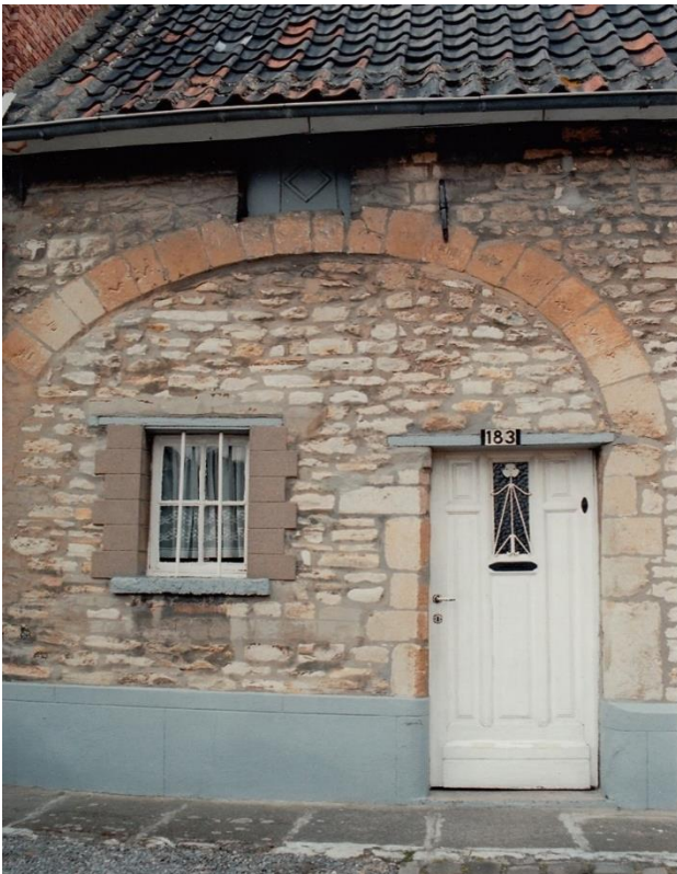
Poddegemstraat 183 – voor verbouwing
